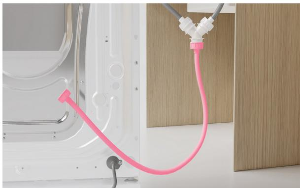
9. 将直管连接到 Y 型接头的底部。
