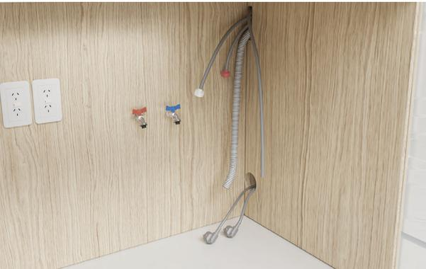
12. 将电源线和软管穿过检修孔。
